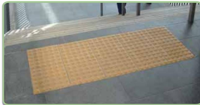
Figura 8 - Una superficie di orientamento tattile indicante un cambio di livello
