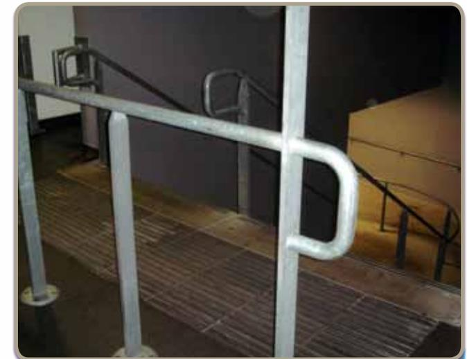
Figura 16 - Pavimentazione tattile (avviso individuabile) con barriera in cima alle scale
